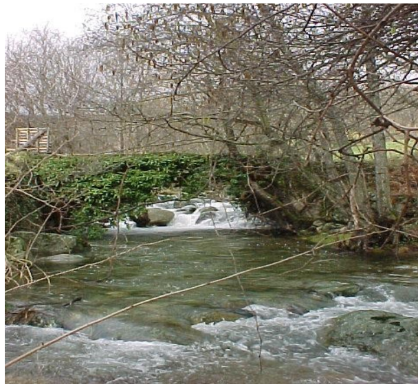
Puente del Tontón
